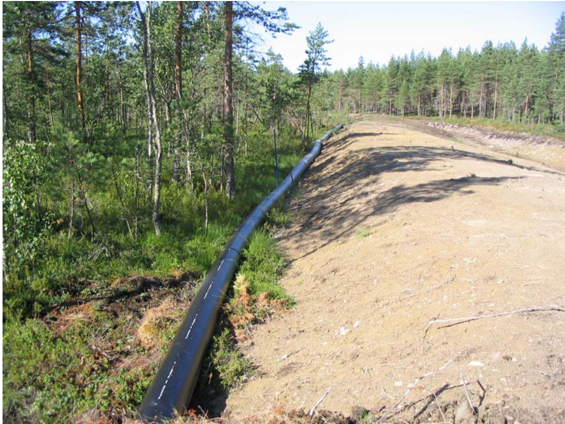
Kuva 4.14.1 Veden johtaminen paineputken avulla pintavalutuskentälle (Kuva Vesa Arvonen 25.7.2007)
