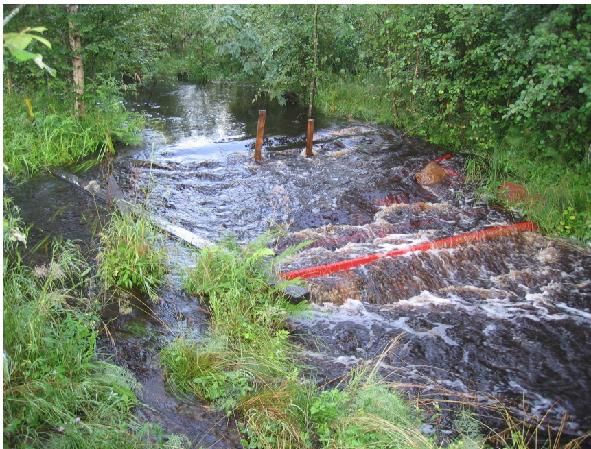
Kuva 3.2.1. Ahmauksenojan hakesuodatin 9.8.2005 virtaaman ollessa 560 l/s.
