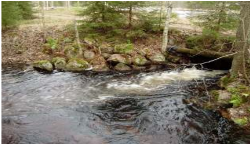
Haukkaojan alemmat siltarummut.
