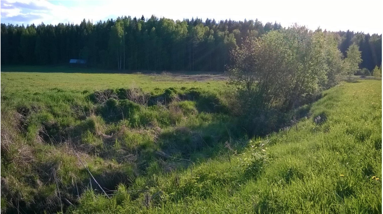
Kuva 8. Siparinojan eroosion seurauksena sortunut ojanreuna Ruokosuon alueella. Kuvan kohteeseen suunnitellaan eroosiosuojaus.
